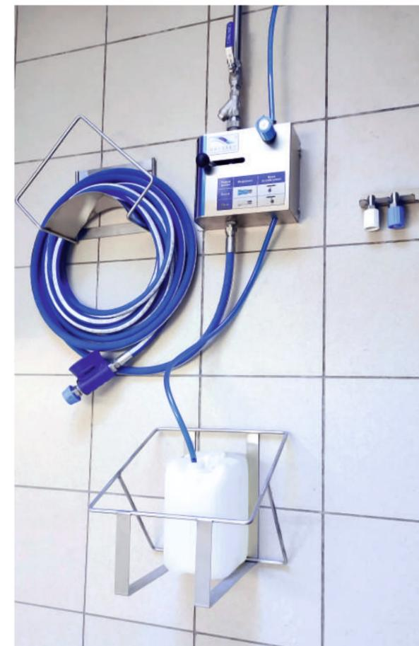
На большинстве небольших пищевых предприятиях давление воды в системе составляет 3-4 бар и устанавливать насосную станцию для работы 1-2 пенных постов нецелесообразно. Именно для таких случаев мы предлагаем использовать пенный пост Odyssey LP.
