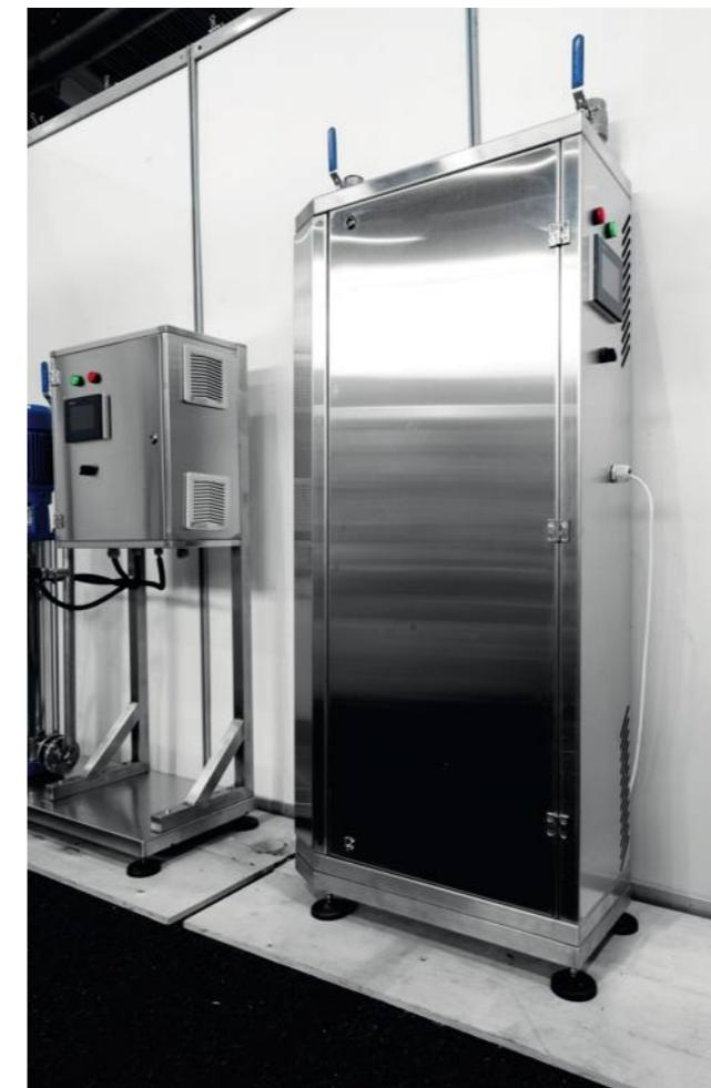
«Необходимое для эффективной мойки повышение давления воды до 20 бар обеспечивается центральной насосной станцией (ЦНС), которая монтируется непосредственно в цеху или в отдельном помещении. ЦНС подключается к существующей на предприятии системе водоснабжения. Тип ЦНС подбирается в зависимости от необходимого количества одновременно работающих постов мойки.
